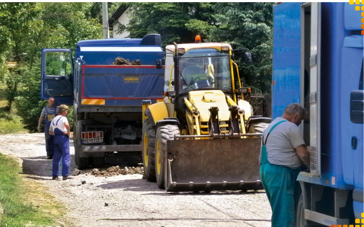
Záber z výkopových prác v máji 2013. Výstavbu realizovala pre obec Nižná Hutka spoločnosť Piemont.
