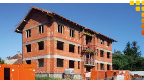
Nájomnú bytovku v Nižnej Myšli stavajú Inžinierske stavby Košice.
