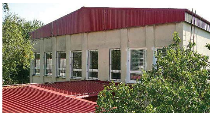
Cez tieto obnovené strechy už voda nemá šancu pretiecť.
