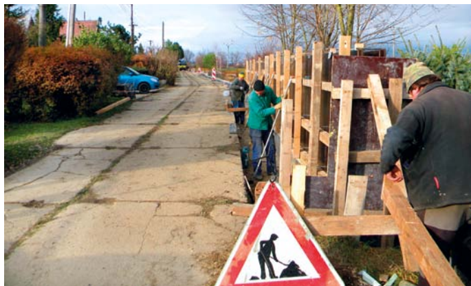
Výstavba protipovodňového valu potrvá v Čani do jari.
