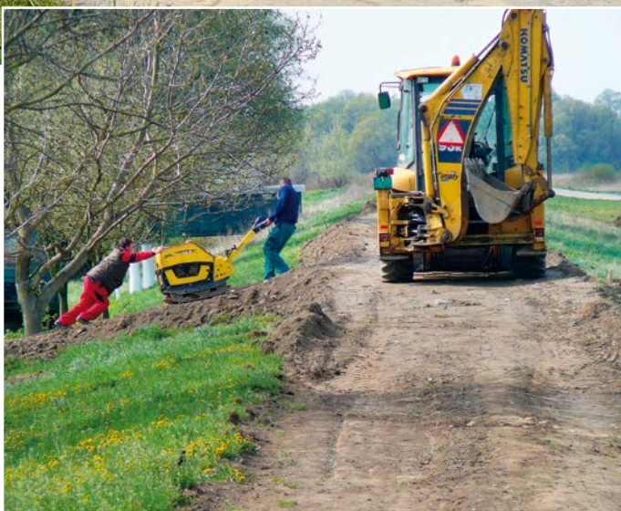
Z prác na oprave hrádze pri obci Trstené pri Hornáde, máj 2016
