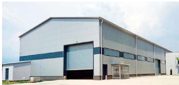
Obyvatelia sa nemusia obávať vysokej hlučnosti. Hala je opláštená kvalitnými tepelno-hlukovoizolačnými panelmi
