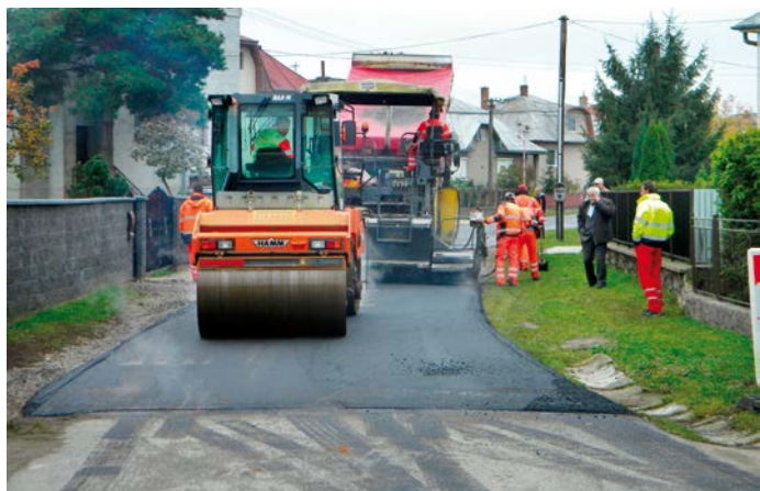
Pokládka asfaltu na čanianskej Jesennej ulici
