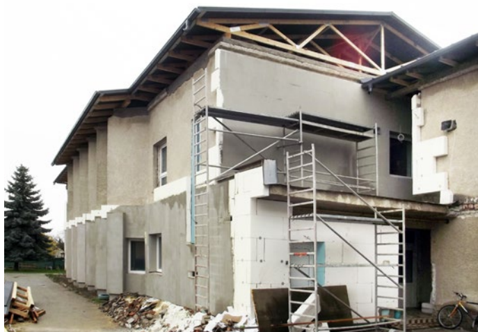
Zvelaďovanie obecných budov – ako napríklad projekt „Zníženie energetickej náročnosti verejnej budovy v obci Kokšov-Bakša“ na snímke – sa môže financovať z kapitálových výdavkov.
