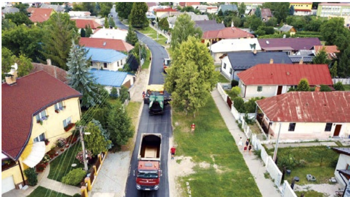
Ulica Mieru s čerstvým asfaltovým kobercom
