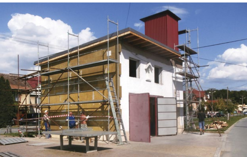
Hasičská zbrojnica pri celkovej obnove
