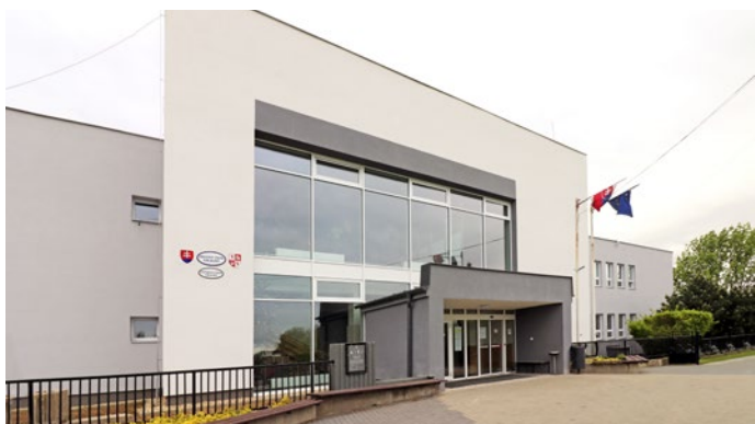
Obecný úrad Valaliky po rekonštrukcii s úspornými technológiami
