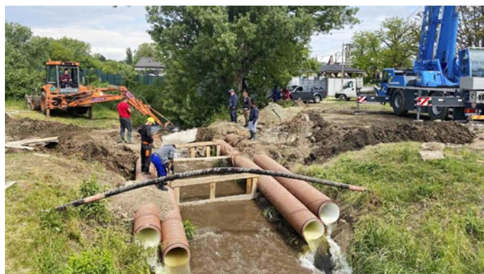
Prepojenie kanalizácie pod sokolianskym potokom
