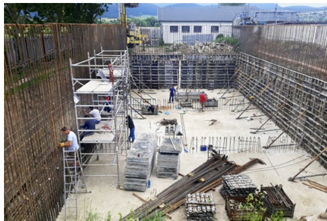
Situácia na stavbe ČOV 15. júna
