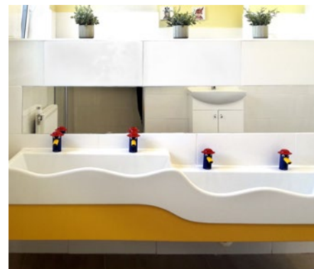
Zrekonštruované WC v materskej škole
