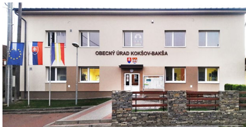
Obecný úrad po rekonštrukcii vyzerá konečne reprezentatívne
