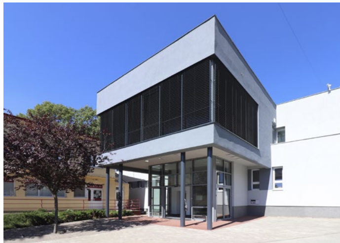
Moderná prístavba úradu poskytuje bezbariérový vstup do budovy
