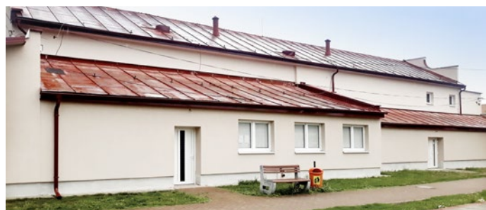
Kino po rekonštrukcii
