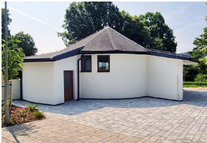
Dnes je z domu nádeje v Skároši opäť dôstojný stánok
