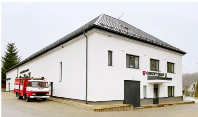
Výzor budovy vo fáze rozostavanosti (vpravo) a dnes
