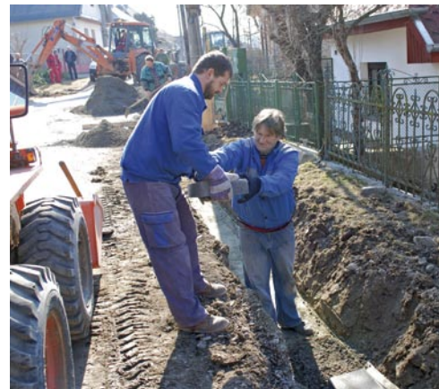
Práca na rígoch vo Vyšnej Hutke.
