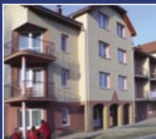
Nová bytovka v Kokšove – Bakši.
