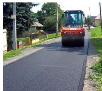
Budovanie cyklotrasy v Gyňove.
