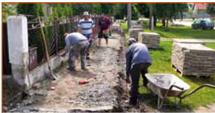
Projekt Revitalizácia obcí s rómskym osídlením pokračuje naďalej. V obci Čaňa od apríla rekonštruujú chodníky na ulici Mieru a Košickej. Projekt bude pokračovať rekonštrukciou a pokládkou asfaltu na ulici Zimnej a Tehelnej.
