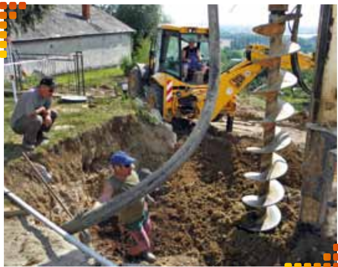
V Nižnej Myšli sú práce s vrtnými súpravami na dennom poriadku.
